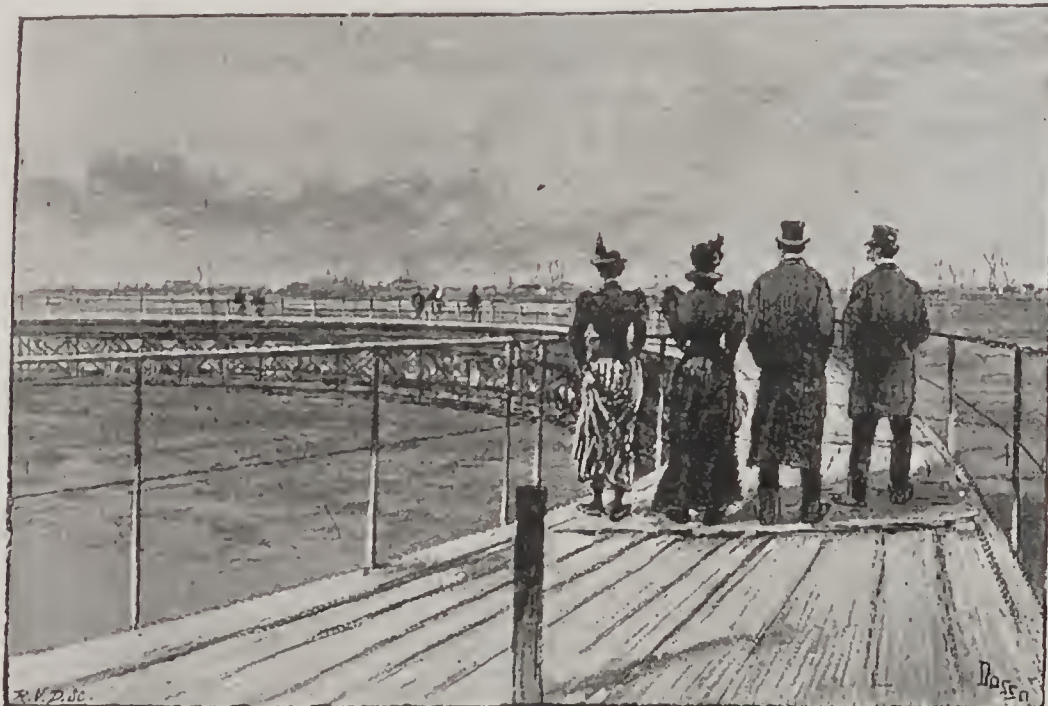
LA PLATE-FORME ÉLECTRIQUE MOBILE. — La voie en marche.
